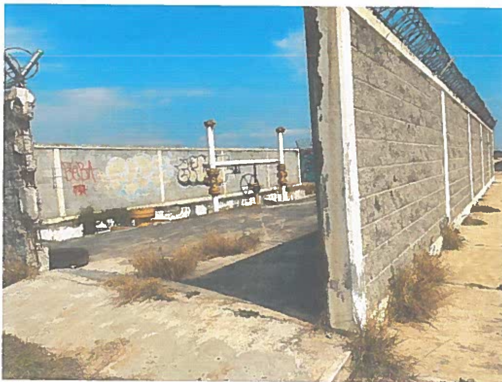
Fotografía No. 13 y 14.- En la imagen se puede observar el camino por donde pasa el gasoducto de Pemex y la estación de válvulas del gasoducto.
