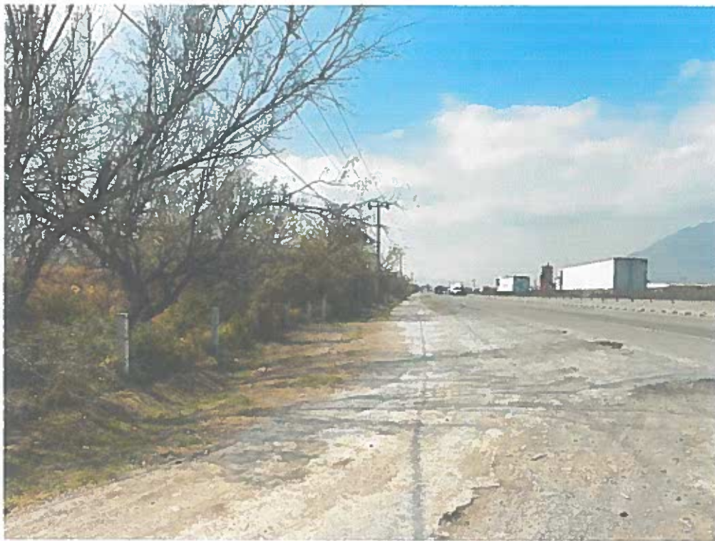
Fotografía No. 15.- Colindancia Norte, aquí se aprecia el libramiento noreste.
